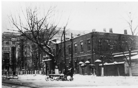
Рис. 28. Здание технического железнодорожного училища в 1930-х гг. (совр. ул. М. Горького, 80). На заднем плане «Профессорский дом», построенный на месте снесённой Успенской церкви (совр. ул. М. Горького, 82) [83]
