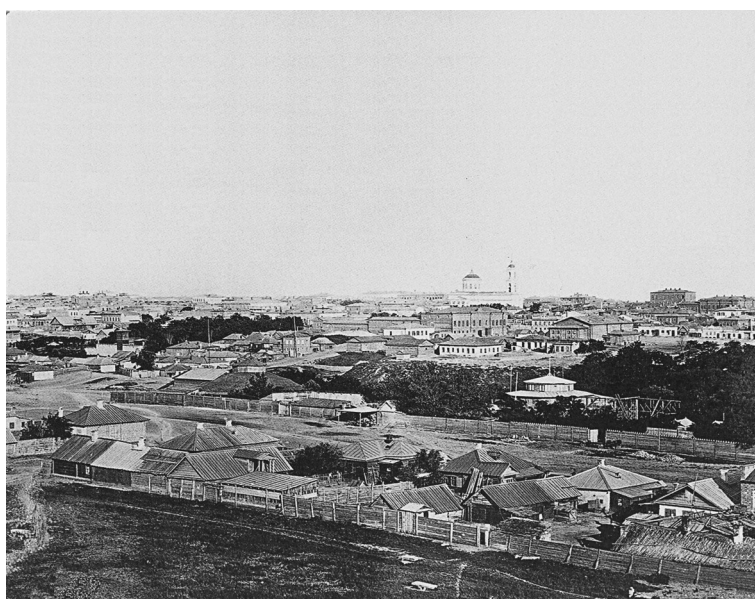
Рис. 14. Обзорное фото 1874–1875 гг., сделанное с одного из зданий пожарного депо (совр. пр. Буденновский, 50 / ул. М. Горького, 78). Вид с северо-запада. Внизу снимка — единственное известное изображение части Всесвятского кладбища [84]
