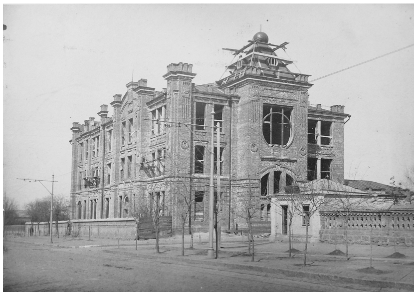
Рис. 17. Строительство доходного дома детского приюта, 1910 г. Сразу после постройки был арендован частной гимназией Степанова (совр. ул. М. Горького, 115). Справа на снимке — дом по совр. адресу ул. М. Горького, 117) [11]. Публикуется впервые
